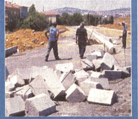
65 milyon 435 bin metre bordür döşendi
